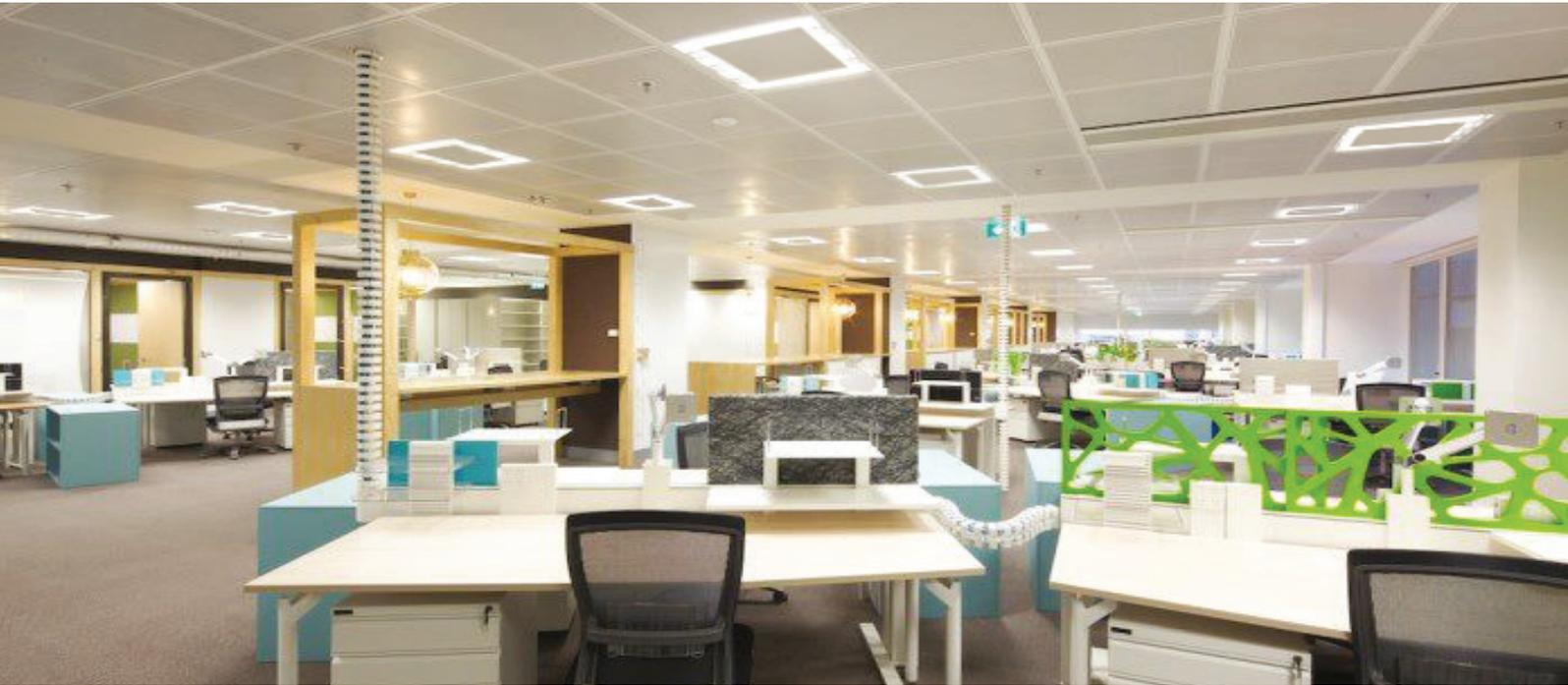
Luminaria de alta eficiencia para iluminación general difusa, de embutir cuadrada, cuerpo de chapa de hierro, para placas de led alta eficiencia. Provisto con fuente externa. Terminación pintura polvo epoxy.
